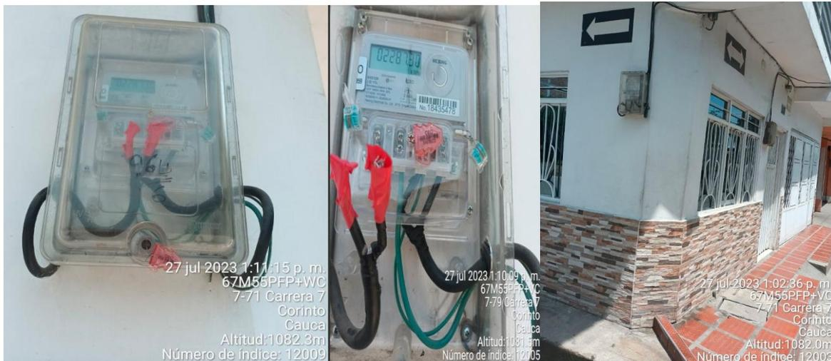
El 29/07/2023 a las 12:43 pm mediante orden No. 10065142 se realiza visita donde se encuentra **“usuario reconectado se procede a ajustar tornillos en bornera se Sella tapa bornera y caja hermética” lectura 02295,14 kWh”**
